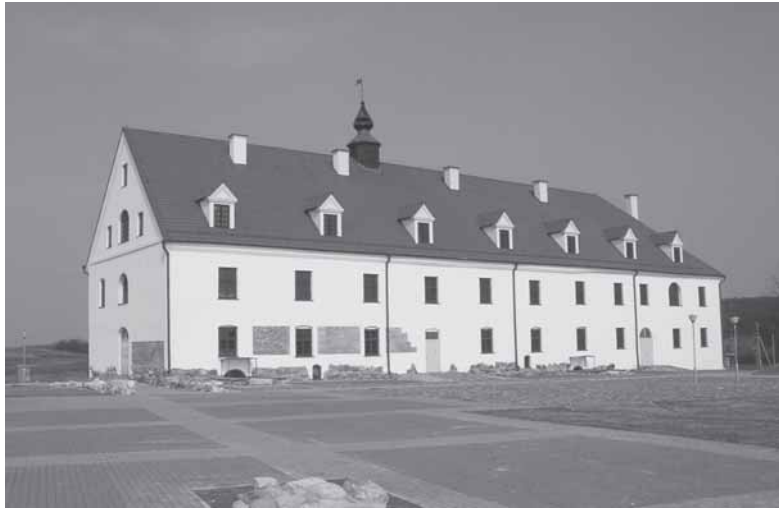
Restauruotas Kražių kolegijos bendrabučio (bursos) pastatas
