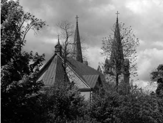
Medingienų bažnyčios (Rėitava savėvaldībė) buokštā. Mukienės Danutės portėgrapėjė
