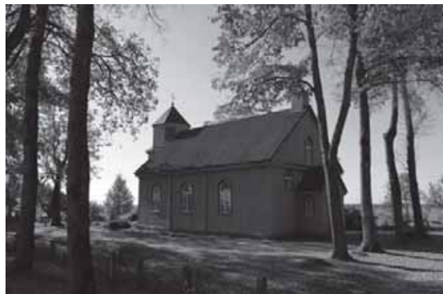
1885 m. Batakių evangelikų liuteronų parapijos bažnyčia (Gerviečių k.)
