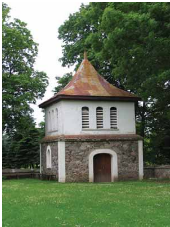
Nedėdėlė, gražiū architektūriņu formu Lėnkėmu varpėnė stuov bažnīčės švėntuoriou
