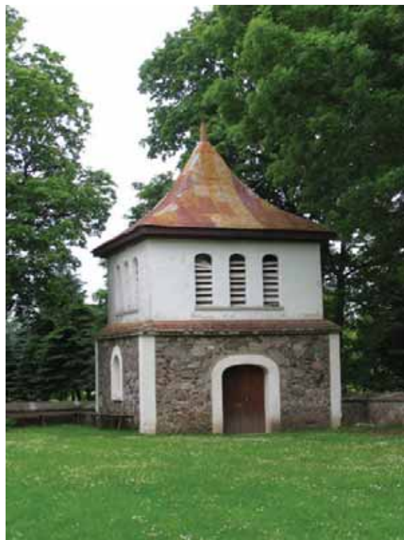
Nedėdėlė, gražiū architektūrinu formu Lėnkėmu varpėnė stuov bažnīčės švėntuoriou
